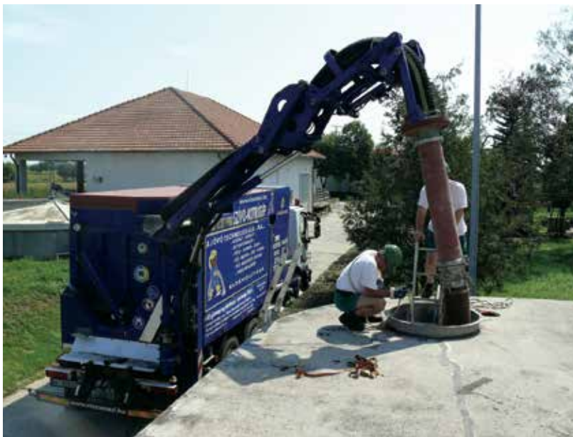
3. kép: Üledékkitermelés az ipari szívó-kotró géppel
