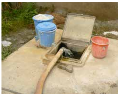
Egy tisztavíz medence vízbevezetése és klórmész adagolási megoldása
