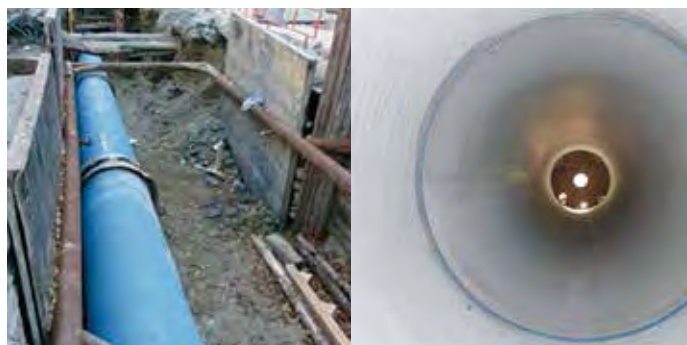
21-22. ábra - Munkagödör kialakítása és az új vezetékszakaszc állapotfelmérése kamerás vizsgálattal
