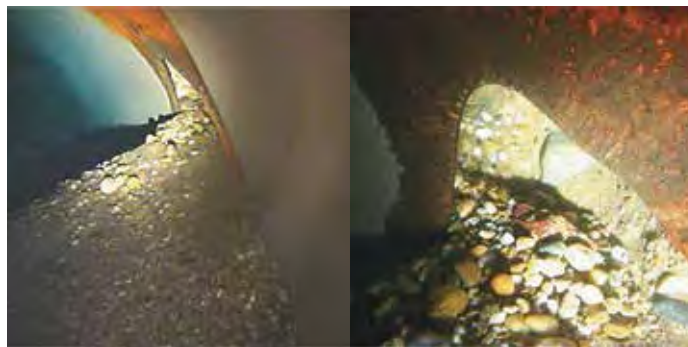
9-10. ábra - Csőfal héjkitörés és Duna meder felőli víz- és hordalékbemosódása
