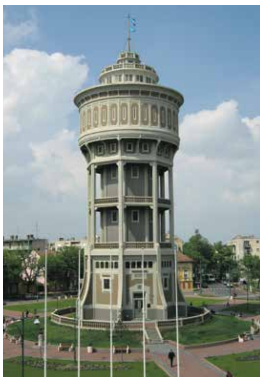
A még ma is üzemelő szegedi víztorony
