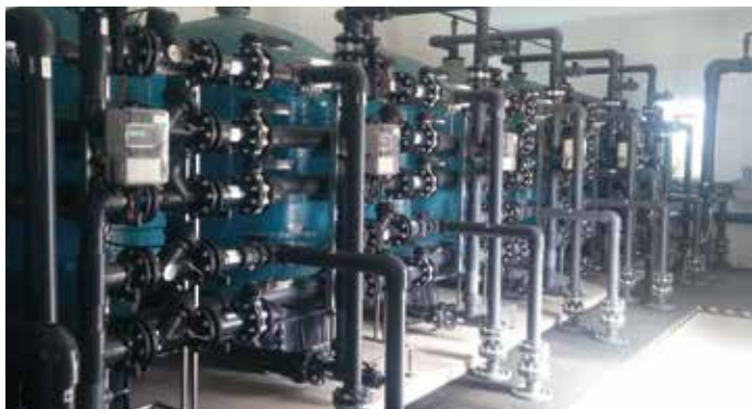
A jánoshalmi víztisztító technológia szűrőtartályai
