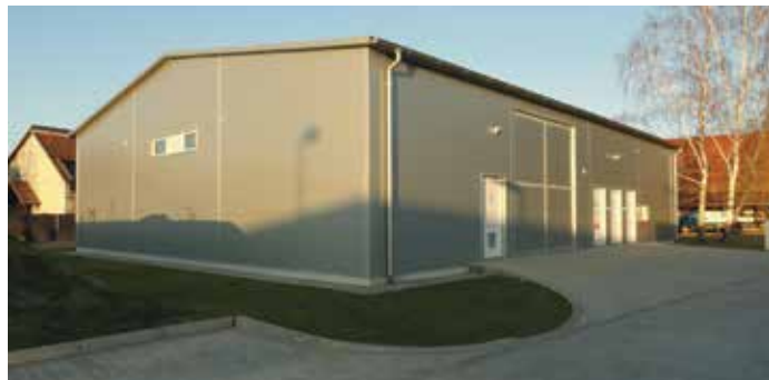
Kecel, vízműtelepi gépház
