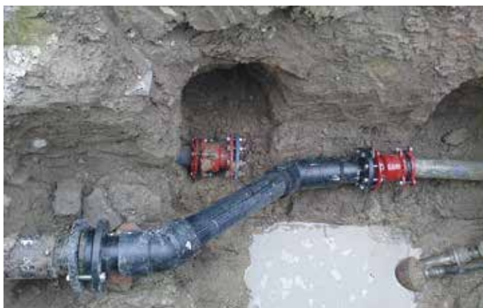
Hálózatrekonstrukció (átkötések idejére két nyomóvezeték párhuzamosan)
