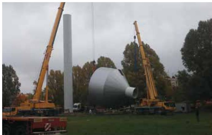
Az épülő kiskunhalasi, 500 m 3 -es víztorony
