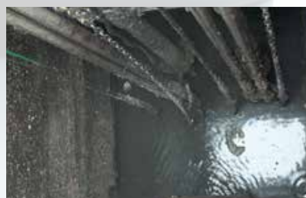
Teszt átemelő a Flygt Concertor™ telepítése után.
