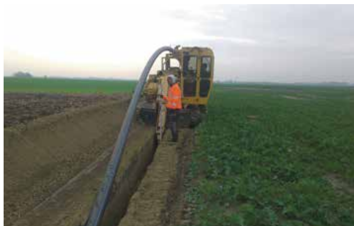
Épülő Dk160 KPE távvezeték
