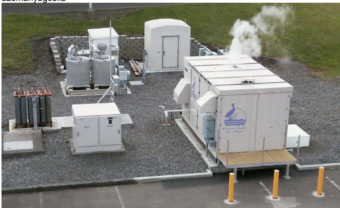
8. ábra: USA Washington állam King megye Déli szennyvíztisztító telepén lévő üzemanyagcella
